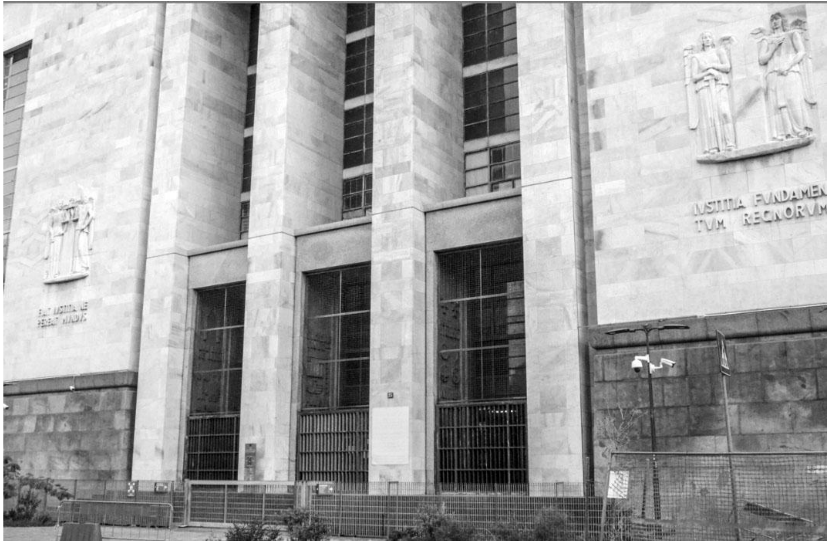
Palazzo di Giustizia, Milano, progettato da Marcello Piacentini, realizzato tra il 1932 e il 1940. In primo piano sculture allegoriche della giustizia di Fausto Melotti
